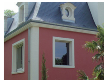
Chaînage et harpage d'angle
